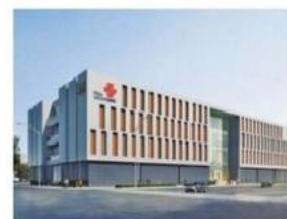
廊坊联通数据库项目
