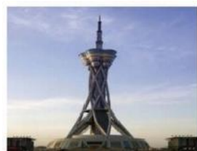
河南广电发射塔工程
