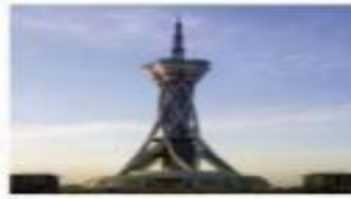
河南广电发射塔工程
